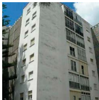
Fachada antes de rehabilitación
